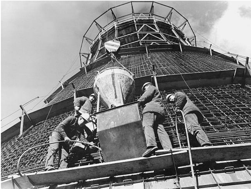
Betonieren des Sockel-Hyperboloids, 1966
