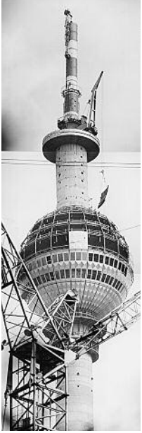
Montage der Kugelfassade, 1968
